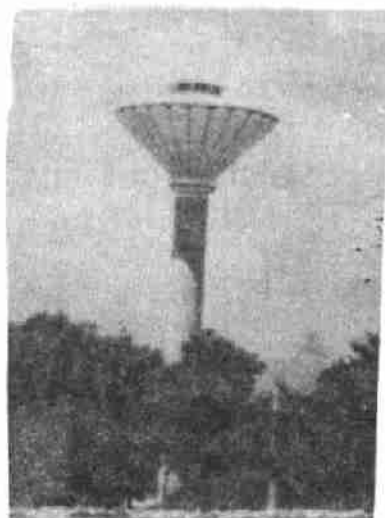
图1 倒锥壳水塔实照
